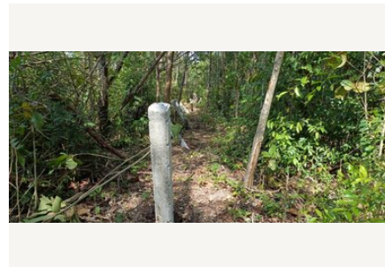
Poste para delimitación del DDV.
